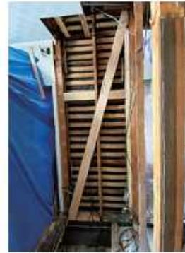
一般的な耐震改修 天井と床を壊して筋交いをいれます
